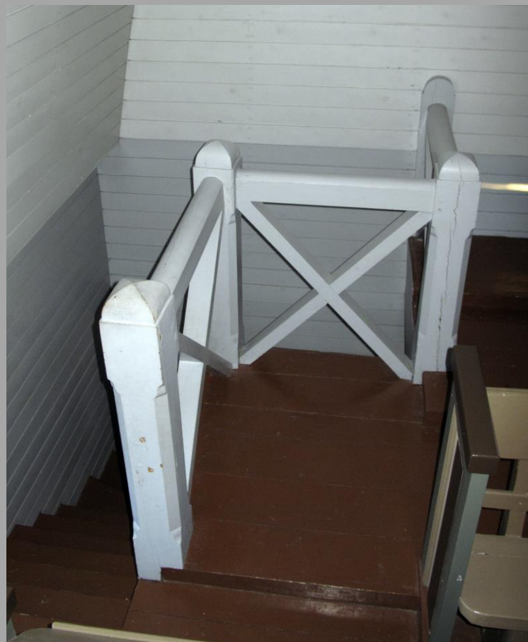
JOS SIVUPARVI "YLEISÖPARVI" PIDETÄÄN AVOINNA PORRASKAITEEN AUKOT TÄYTYY TUKKIA
