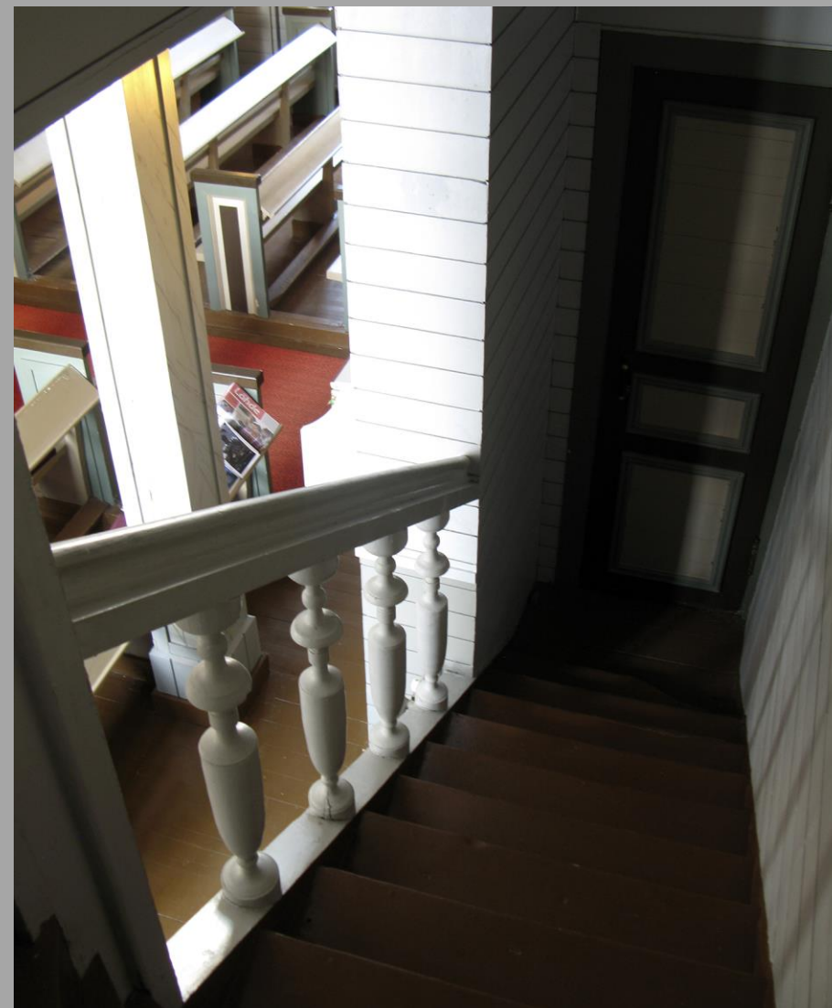
JOS SIVUPARVEN OVI ON LUKOSSA JA SINNE EI PÄÄSTETÄ LAPSIA, KAITEET VOIVAT OLLA NYKYISET, ILMAN LISÄOSIA
